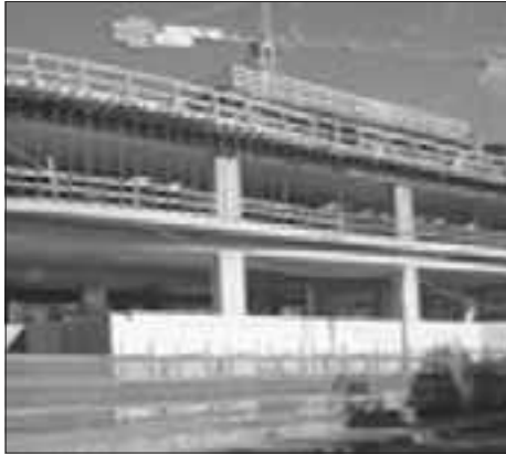
Il cantiere della ditta Romani
