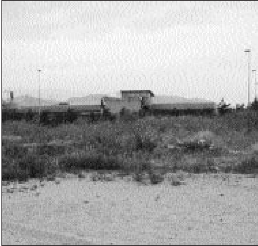
A Botricello uno dei depuratori più attivi della zona
